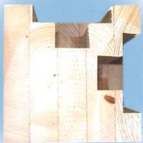
通柱と胴差加工 通柱と金具取付用ボルト穴 (米松集成材 120×120)
