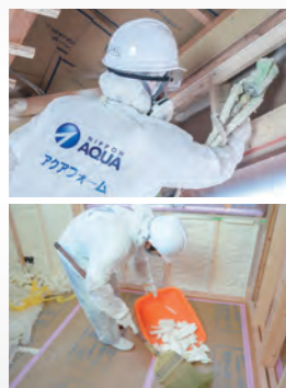
現場施工・端材回収
